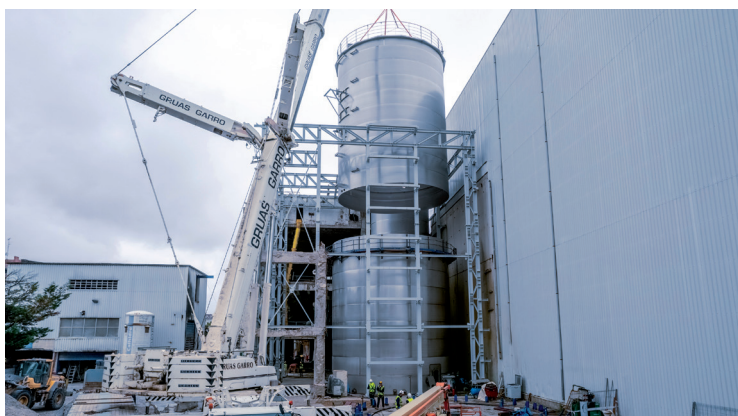
La nueva depuradora, del fabricante vasco Cadagua, funciona con tratamiento anaerobio. El metano generado puede ir a un quemador específico de la caldera para hacer vapor.
