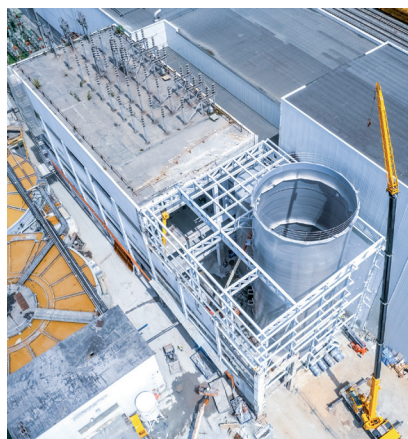
La nueva depuradora, del fabricante vasco Cadagua, funciona con tratamiento anaerobio. El metano generado puede ir a un quemador específico de la caldera para hacer vapor.
